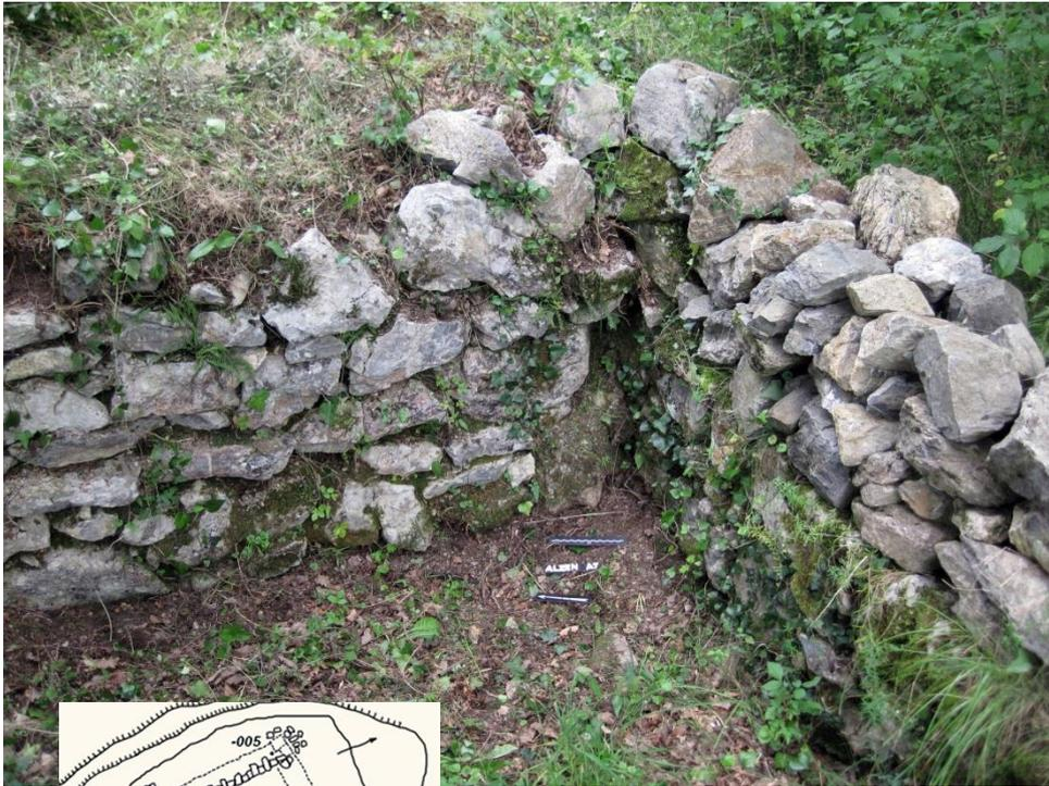
*Jonction de l'angle sud-ouest de la Tour et du mur qui se développe du nord-est vers le sud-ouest sur plus de trente mètres... Les murs ne sont pas chaînés.*
