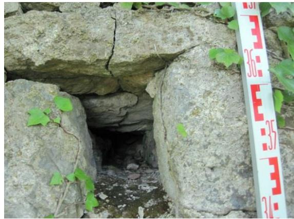
*Plusieurs trous existent dans le « Grand Mur ». Il ne s'agit pas de trous de boulin mais d'orifices qui permettaient de drainer l'eau qui pouvait s'accumuler derrière le mur*
