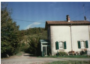
Garde barrière n° 53 « La Glaise », passage à niveau avec la route de Baliar
