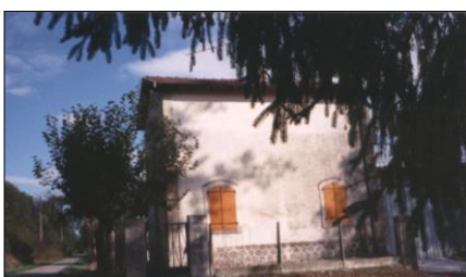
Garde barrière n° 39 de Luzenac, passage à niveau avec la D 815
