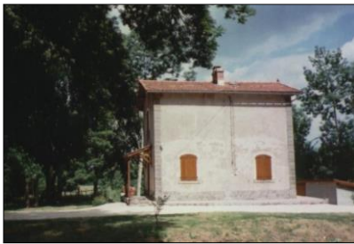
Garde barrière n° 42 de la Plane, passage à niveau avec un chemin communal
