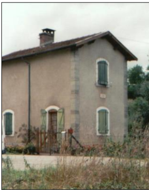
Garde barrière n° 48 de Soueich de Bau, passage à niveau avec la route du même nom
