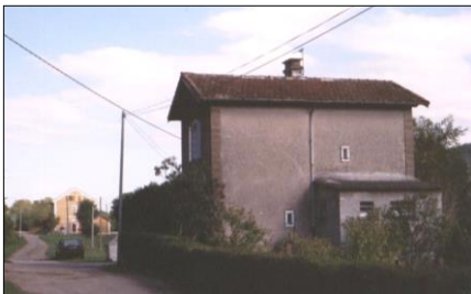
Garde barrière n° 38 de Ribots, passage à niveau avec une route secondaire
